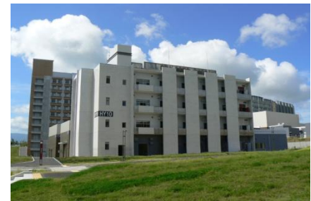
水素材料先端科学研究センター (HYDROGENIUS) 実験棟 H19年11月完成
