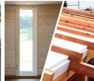
樹脂サッシ・外断熱による高断熱化
