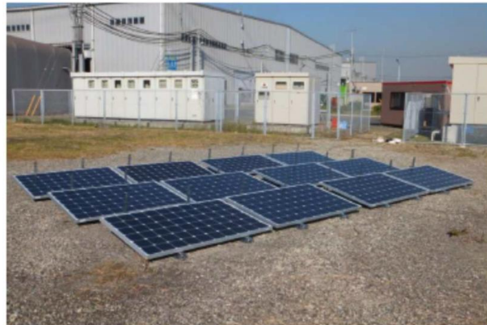
使用済PVパネルの設置写真 (12枚セット)
