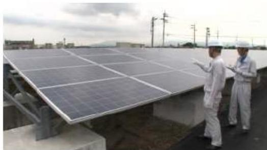
図 太陽電池モジュールの外観検査
