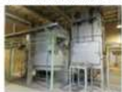
<Li-ion電池リサイクル設備>
