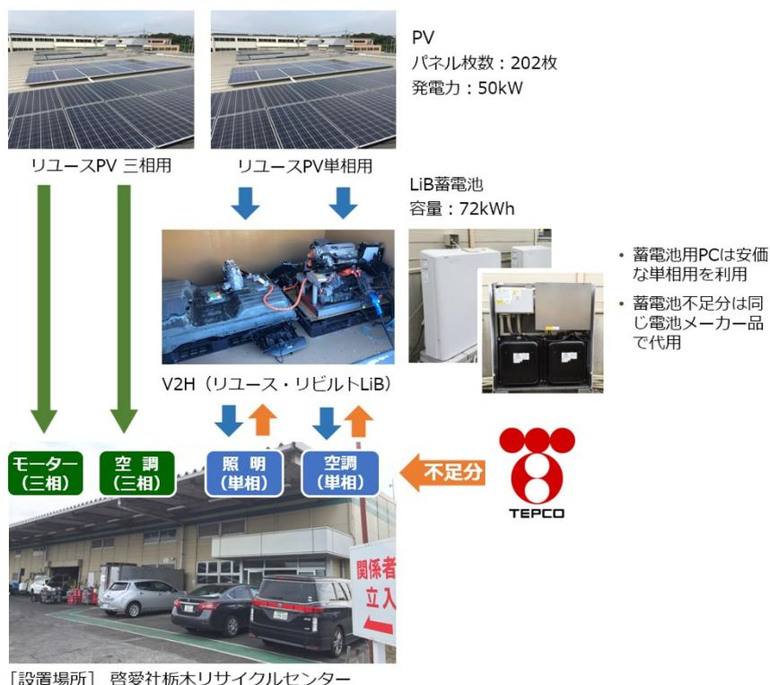
図 2.2.1 低炭素電力システムの設置状況
