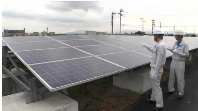
図表 55 太陽電池モジュールの外観検査
