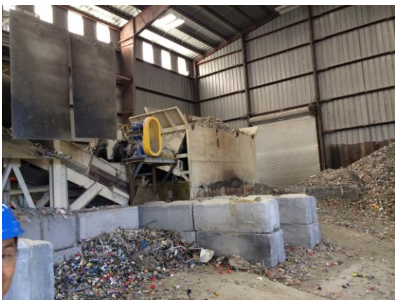
重プラ・ガラス MIX を分級し選別装置へ投入
