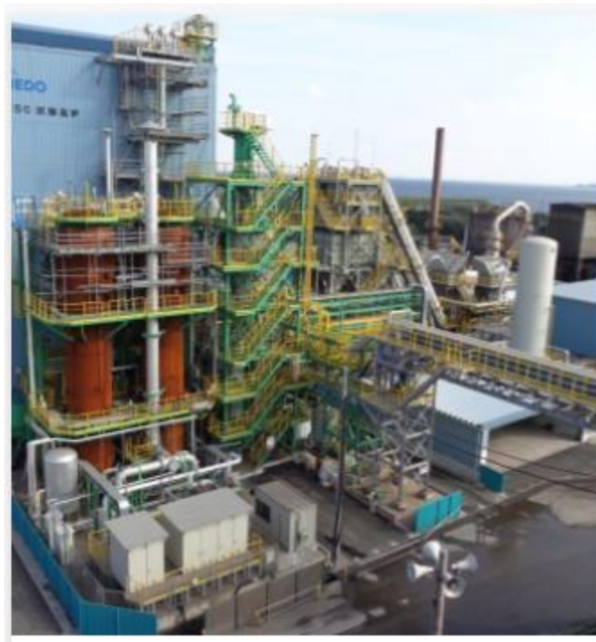
【写真】鉄鋼大手コンソーシアムとNEDOによる水素還元実験炉 (@君津) (出典：(一社)日本鉄鋼連盟HP)
