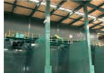
ダスト保管ヤード
