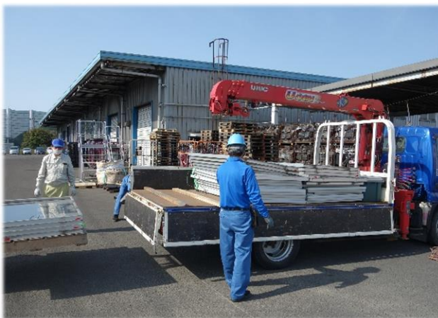
使用済パネルの運搬の様子
