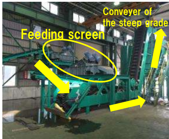
② 投入したパネル破砕屑は、原料供給コンベアで運ばれ2つのフィードスクリーンでふるいにかける。一定粒径内の破砕屑は急傾斜スケールコンベアを経て選別機本体へ運ばれる。
