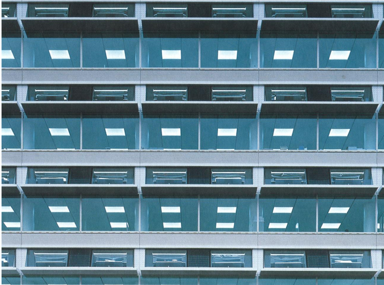
外部から自然光を取り込む採光部。室内の照明は自然光。
