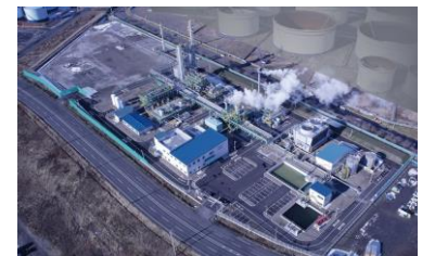
炭素回収・貯留施設
