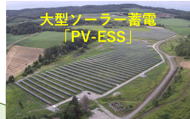
大規模発電所
