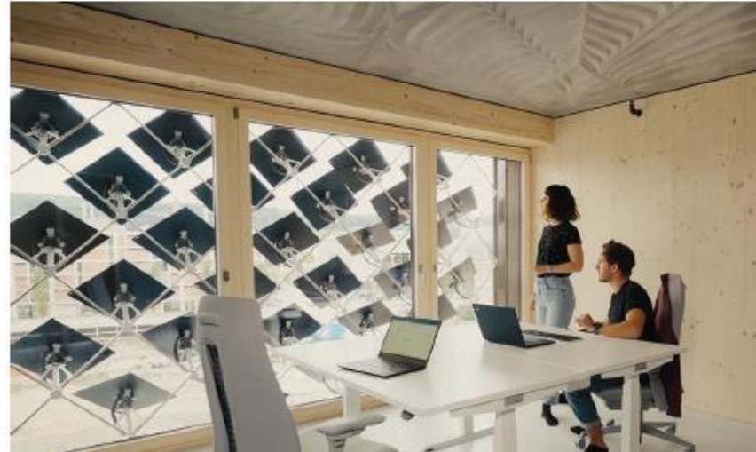
ETHが開発したダイナミック・アクティブ・シェーディング・デバイス
